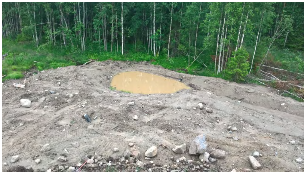
KUVA 5 Laskeutusallas ja laskeutusaltaan läpivienti
