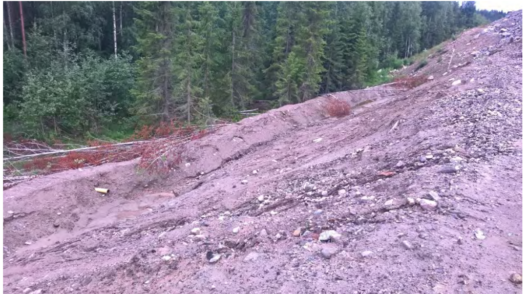
KUVA 4 Lämpivienti vesien purkamiseksi läjitysalueen pohjoisosassa ennen pintamaavallia
