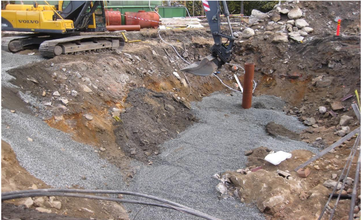
Kuva 9. Kuvassa pumppukaivo asennettuna rammeroituun syvennykseen ja salaojaputket paikallaan 7.10.2016. Putket ja kaivon sakkapesä, sekä tuloyhteet sepelikerroksen sisällä.
