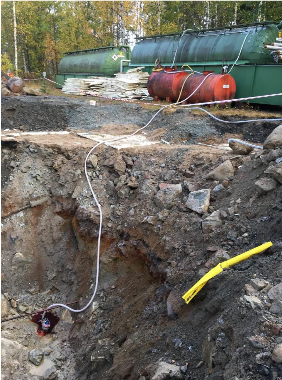
Kuva 2. Öljyn pumppausta kallionkoloista säiliöön. Seassa vettä, mutta pumppauksen edetessä loppuvaiheessa suhteellisen puhdasta öljyä, kuten kuvan tilanteessa näkyy.
