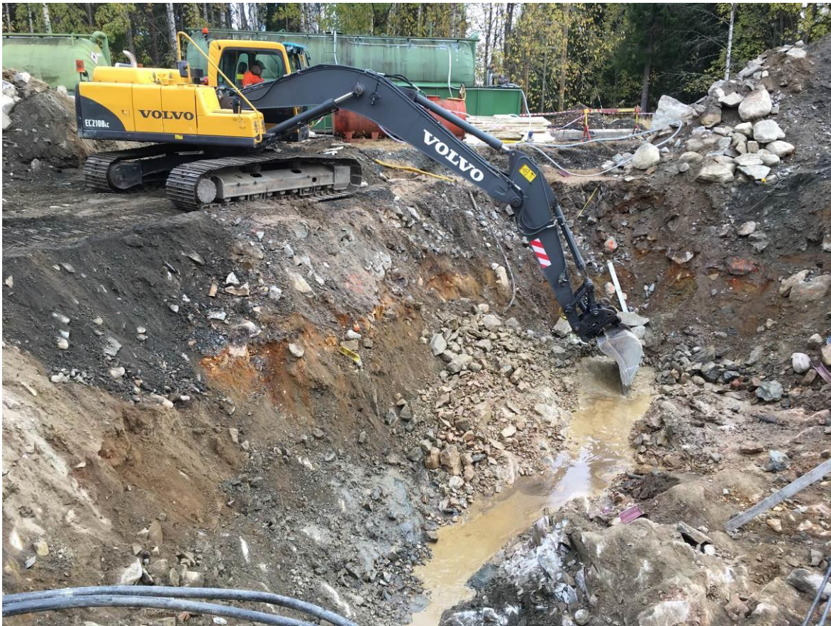
Kuva 4. Pumppauskaivon / siiviläkaivon alueelta irtolouheen ja kivien poisto. Riittävät laskupinnat varmistettu veden virtauksen tehostamiseksi.
