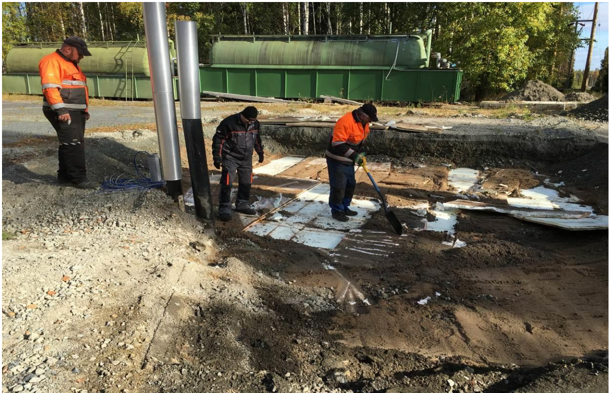
Kuva 3. Aitaus poistettu ja säiliöt on siirretty (kuvassa taka-alalla). Kunnostustyö on aloitettu 20.9.2016. Vuotoalueelta murskeet poistettu ja eristekerros näkyvissä. Öljy oli levinnyt eristeen päällä ja reuna-alueilta valunut alaspäin.
