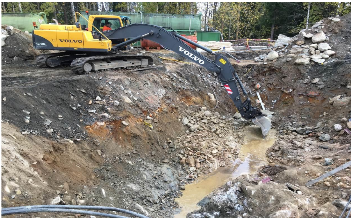
Kuva 8. Pohja-alueen rammerointi valmis. Pohjalle saatiin "ojasto" ja pumppaussyvennys kaivolle.
