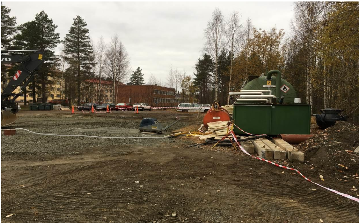
Kuva 10. Kuvassa kaivantoalue täytetty ja tiivistetty. Pumppaus kaivosta välisäiliönä toimineeseen öljysäiliöön (vihreä 25 000 litran säiliö) ja siitä edelleen öljynerottimen kautta maaperään.
