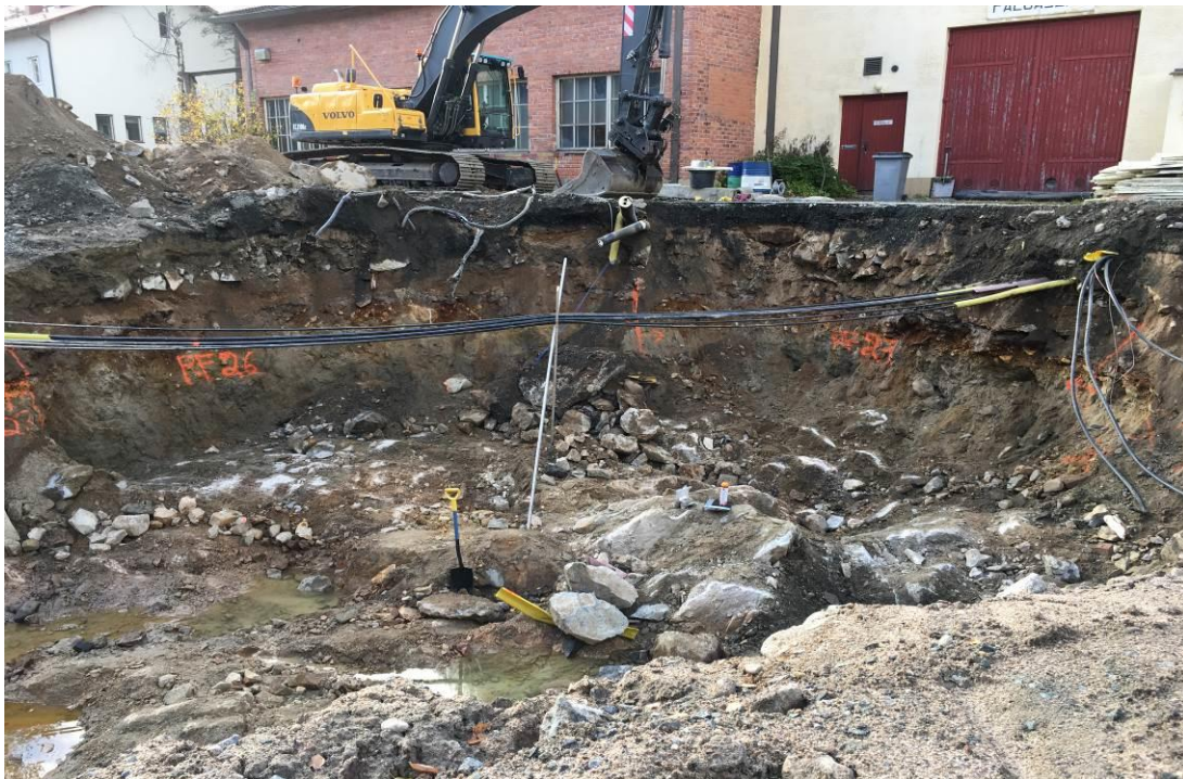
Kuva 6. Kallionpinta kaivettu näkyviin koko pohja-alueella. Kaivantoseinämät puhtaat.
