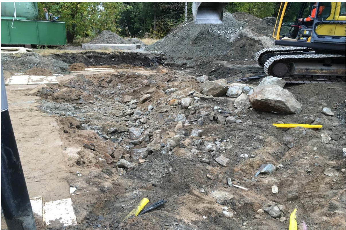
Kuva 4. Eristekerroksen alapuolella ohut hiekkakerros, jonka jälkeen alkoi louhetäyttö (kivikko).
