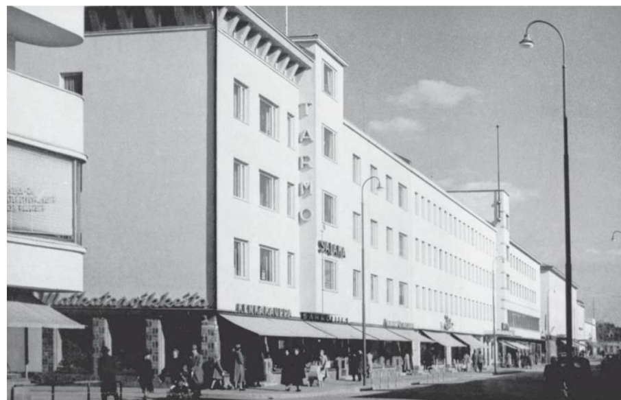
Pitkäsen suunnittelemia rakennuksia Kauppakadun varrella 1950-luvun puolivälissä, etualalla Kauppakatu 15. (Kuva Kauppila 2008).
