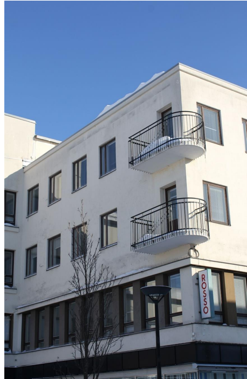
Kiinteistön IV-kerroksisen osan funktionalismin muotokielen mukaiset parvekkeet Raatihuoneentorin ja Kauppakadun kulmauksessa.
