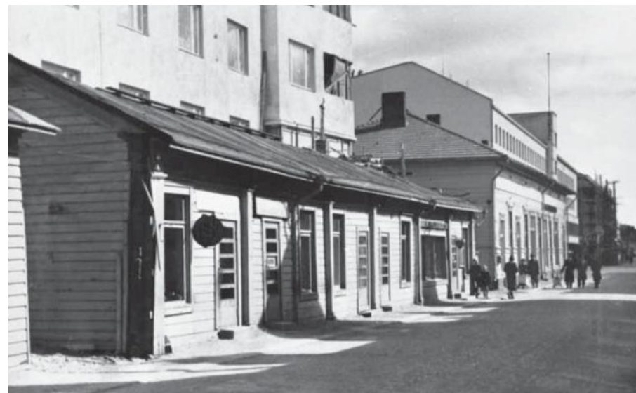
Korhosen talo osoitteessa Kauppakatu 17 keväällä 1951. Kirkkokadun puoleinen siipi on jo purettu pois uuden asuin-liikeyrakennuksen tieltä. Uusi nelikerroksinen rakennus on rakennettu uuteen katulinjaan vanhan puutalon taakse. (Kuva Kauppila 2008).
