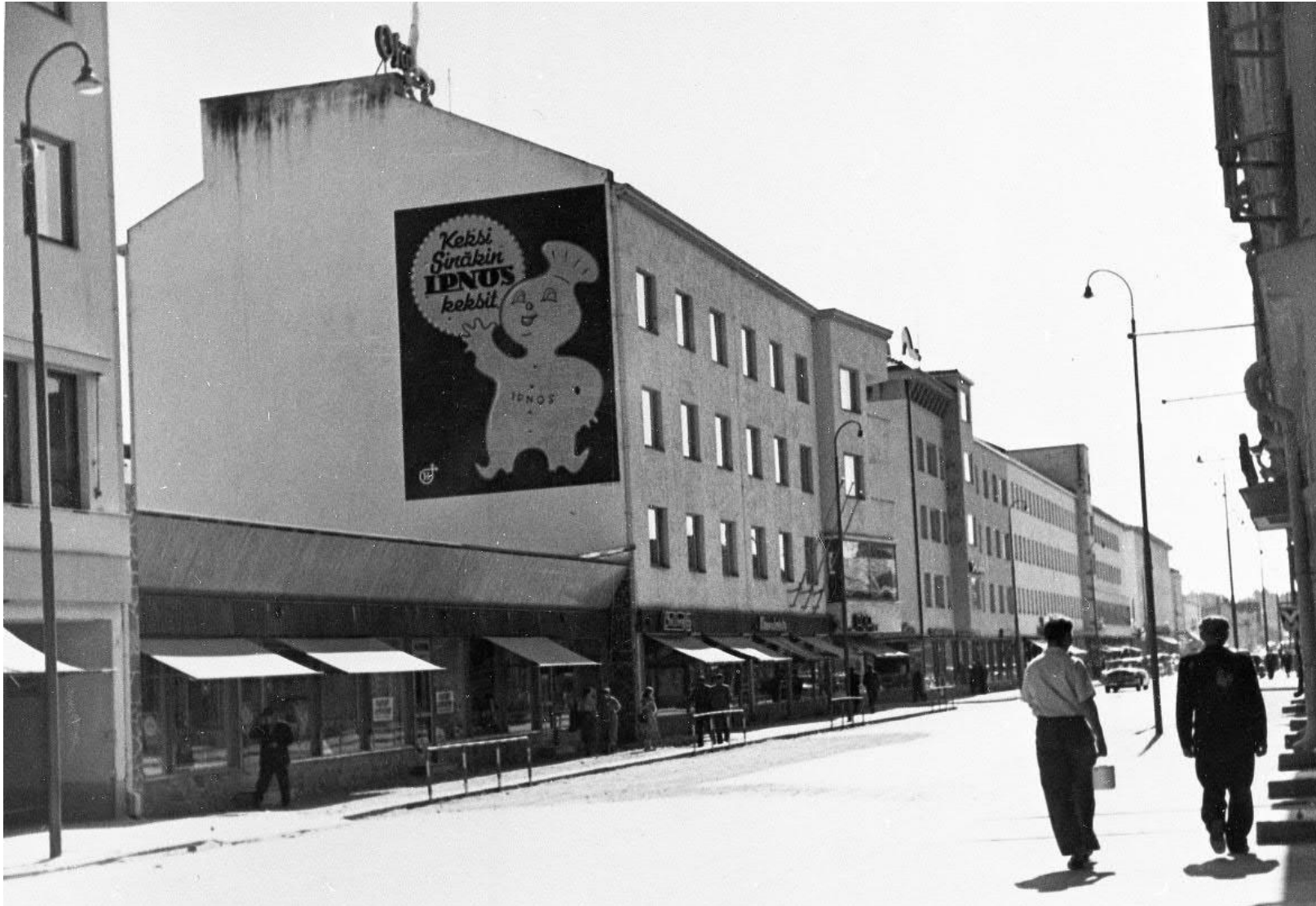
Kauppakadulta otettu kuva noin vuodelta 1960. Etualalla Kauppatu 19 alta purettu rakennus. (Kuva: Kainuun Museon kuva-arkisto/Tauno Rissanen)
