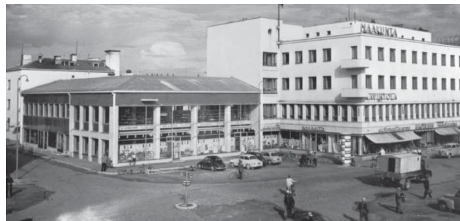
Osuuskauppa Maakunnan hotellirakennus ja liikerakennus vuonna 1957. (Kuva Kauppila 2008).
