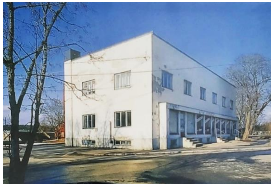
Osuusliike Aitta Sauvossa on Erkki Huttusen 1930-luvulla suunnittelema. Rakennus on aikakautensa tyylipuhtaimpia esimerkkejä ja rakennussuojelulain nojalla suojeltu. (Kuva Nikula 2005).
