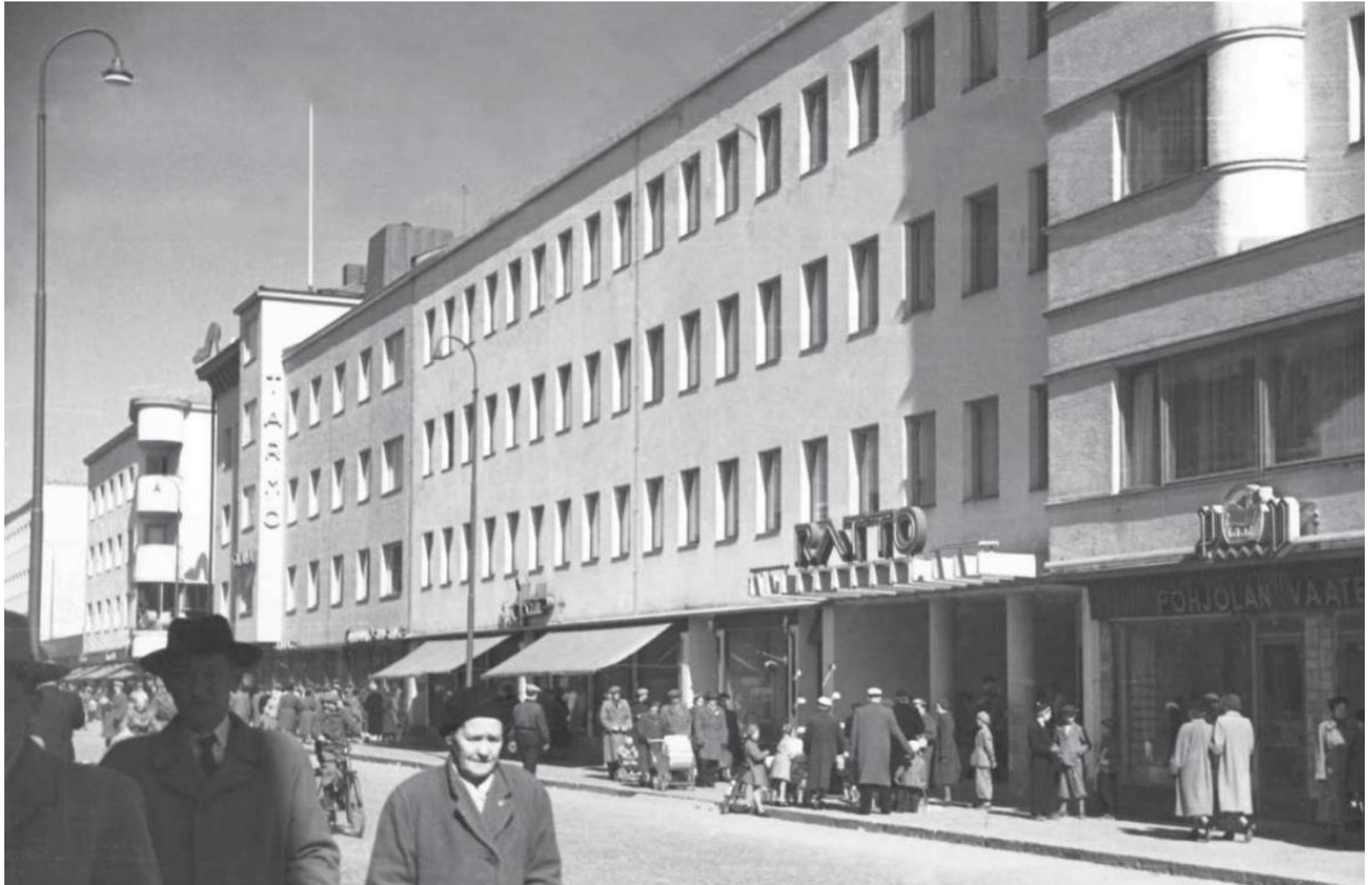
Pitkäsen suunnittelemassa Ipatin talossa (Kauppakatu 13) toimi 1950-luvulla elokuvateatteri Ratto. Sen takana näkyvät Kauppakatu 15 ja Kauppakatu 17 ovat niin ikään Pitkäsen suunnittelema. (Kuva Kauppila 2008).
