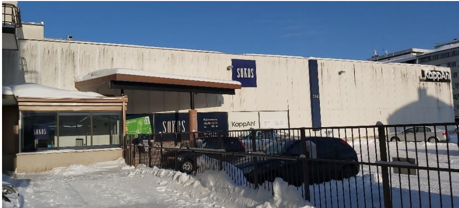
Rakennuksen julkisivu kiinteistön 17 ja Kirkkokadun suuntaan. Julkisivua hallitsee yhtenäinen, pystysaumainen teräslevybetonilevy pinta, jota elävöittää sisäänkäynnin tyylielty katos sekä nauhaikkuna.
