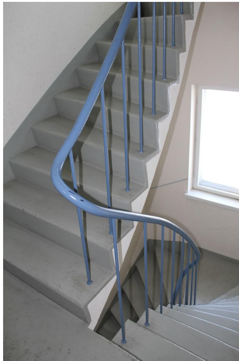
Rakennuksen nelikerroksisessä osassa on useita porrashuoneita. Kuvassa porrashuone sisäpihan puolella.
