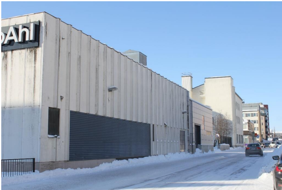
Rakennuksen julkisivu Välikadulle. Julkisivua nykyasussaan hallitsee pystysaumainen teräslevybetonilevyistä muodostuva pinta, johon tuo kontrastia väritykseltään tumma aaltolevy pinta. Materiaalikontrastia aiheutuu myös myöhemmin rakennetusta liikennöinnille tarkoitetusta laajennuksesta.
