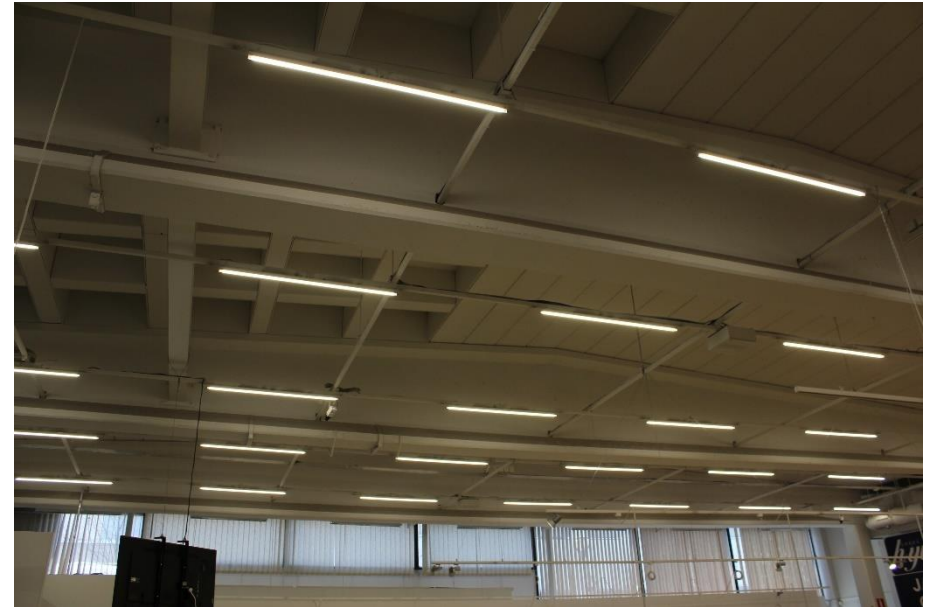
Ensimmäisen kerroksen avara myyntitila on säilynyt tilana pitkälti alkuperäisenä, mukaan lukien tilan sisäkattorakenteet.
