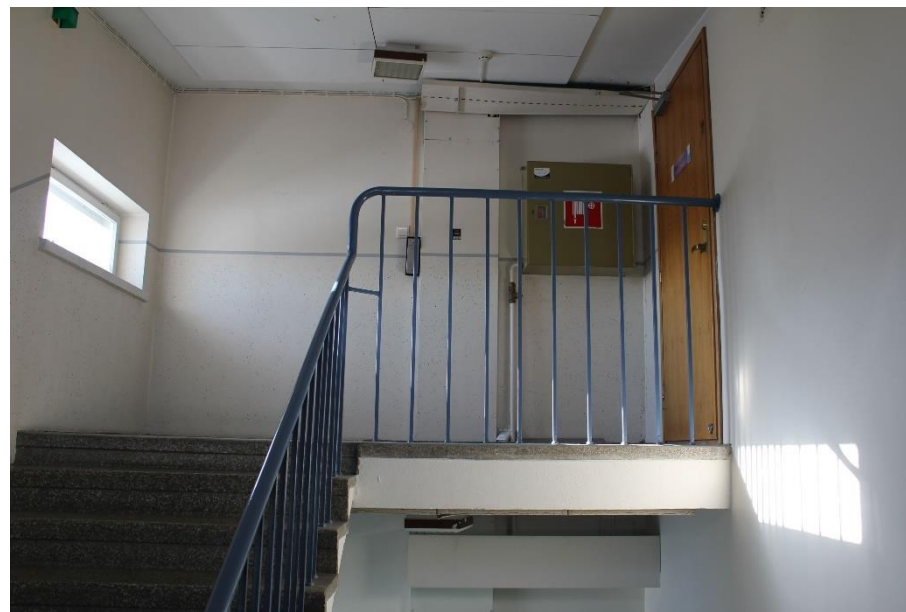
Porrashuoneiden kautta on käynti rakennusten eri tiloihin. Kuvassa käynti ullakkotiloihin. Useiden tilamuutosten yhteydessä kulkuyhteydet ovat muuttuneet alkuperäisestä pohjaratkaisusta.
