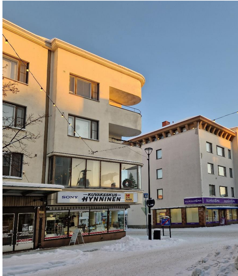
Kuva 7. Kauppakatu 17 kaarevat parvekkeet Kauppakadun ja Kirkkokadun kulmauksessa. (Väyrynen, 2024)
