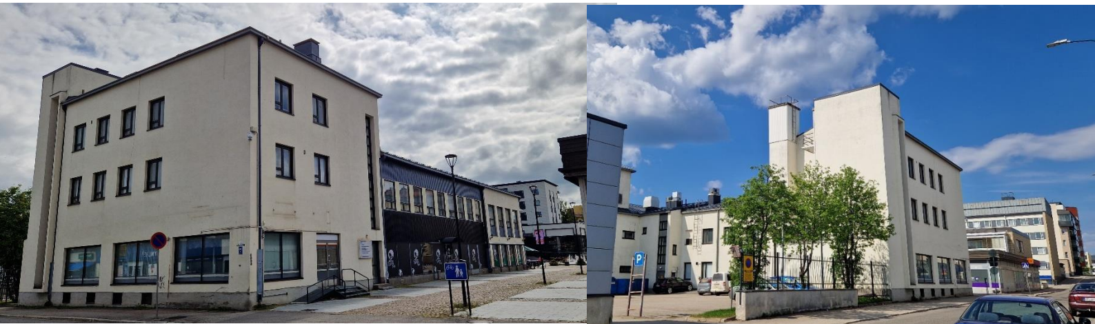
Kuva 11. Kauppakatu 21 sijoittuvat kaksikerroksinen liikerakennus sekä kolmekerroksinen liike-asuinrakennus. (Väyrynen, 2024)
