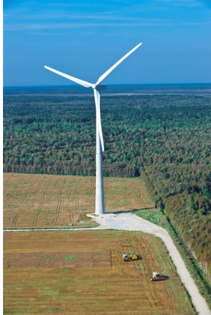
Kuva 3. Kuva teräsbetonirakenteisesta tuulivoimalasta ja periaatekuva tuulivoimalasta (Lähde: WinWind Oy).
