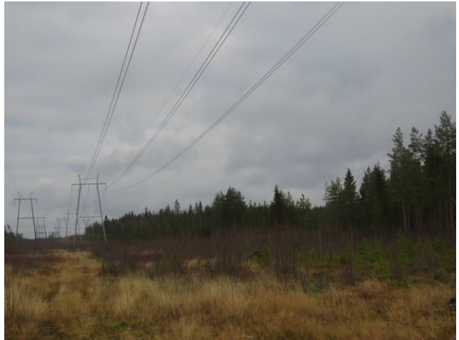
Kuva 22. Linja Tervosuon kohdalla, koilliseen.
