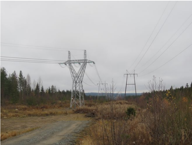
Kuva 21. Voimalinja hankealueen koillisreunalta koilliseen.
