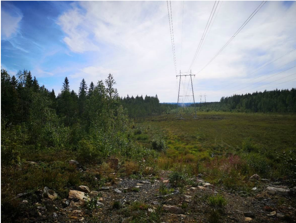
Kuva 4-9. Olemassa olevaa johtoaukeaa Rynnäsentieltä etelään päin kuvattuna. Suunniteltu uusi voimajohto vaihtoehdossa 2 on tarkoitus toteuttaa olemassa olevan johdon itäpuolelle (kuvassa olemassa olevasta johdosta katsoen vasemmalle puolelle).
