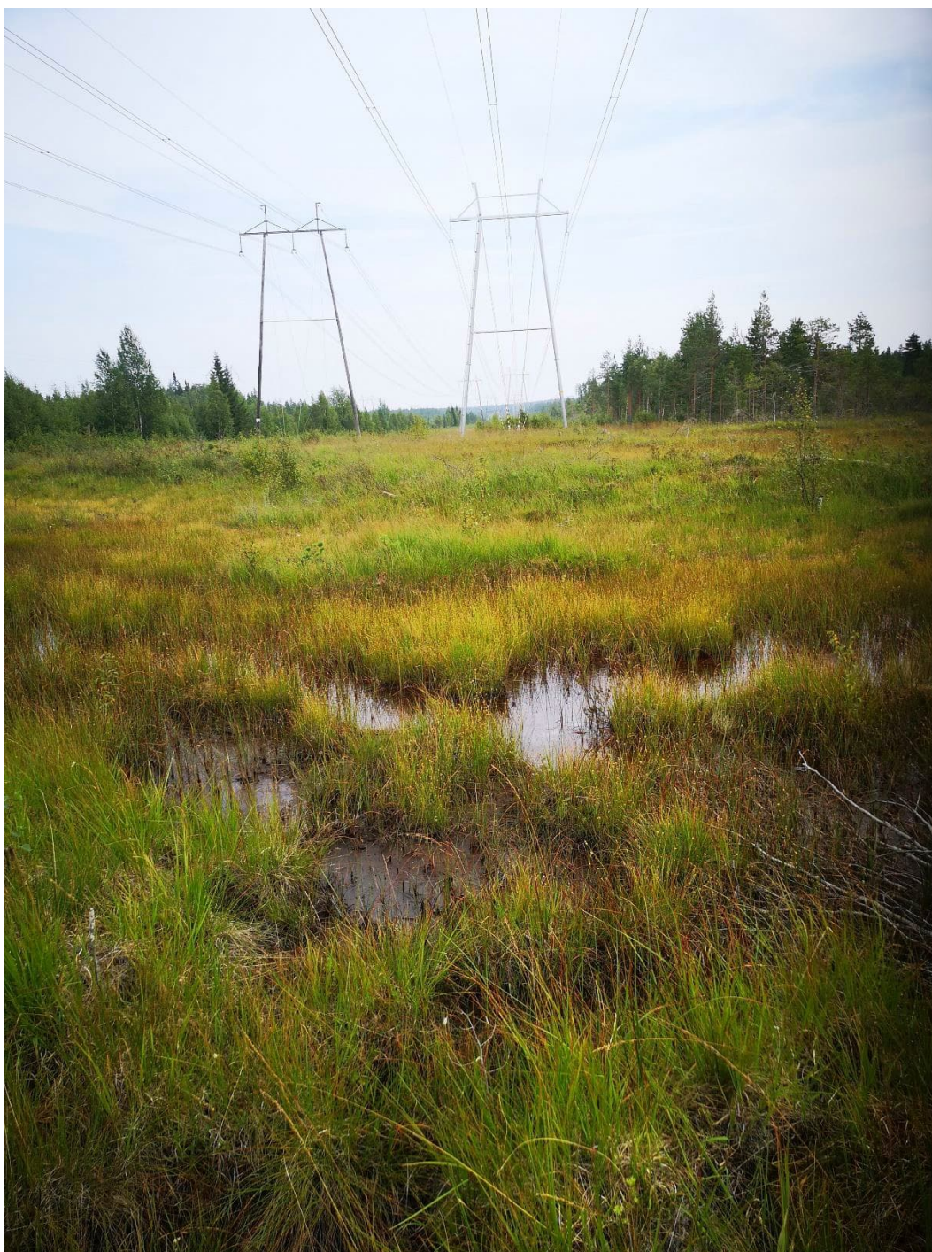
Kuva 4-11. Radan molemmin puolin sijoittuvat olemassa olevat voimajohdot sekä reuna-alueen rimpipintaa Kotasuolla.
