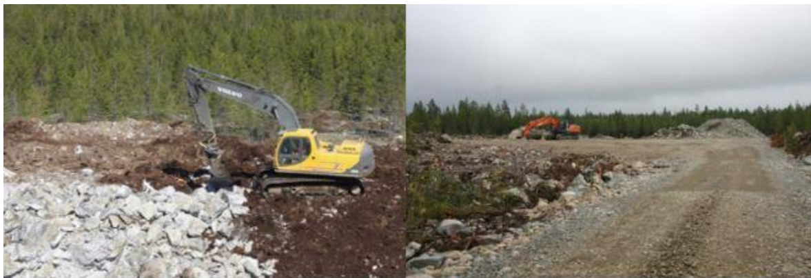
Kuva 25. Tuulivoimapuiston rakentaminen alkaa huoltoteiden ja pystytysalueiden rakentamisella (FCG).
