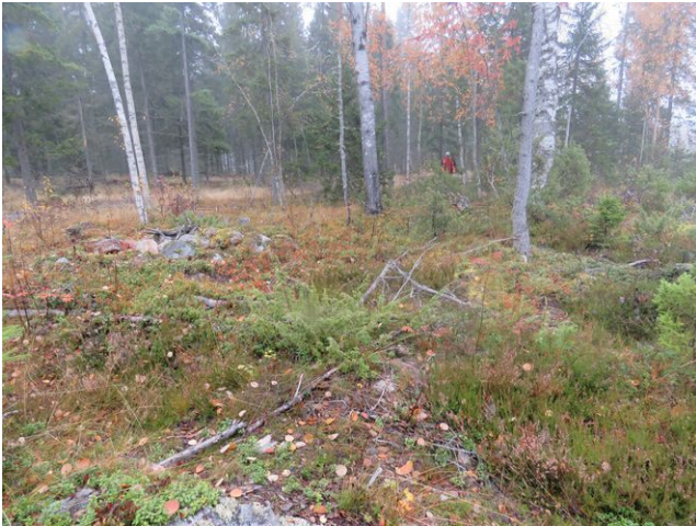
Alakohde 73-2, rakennuksen perustus
