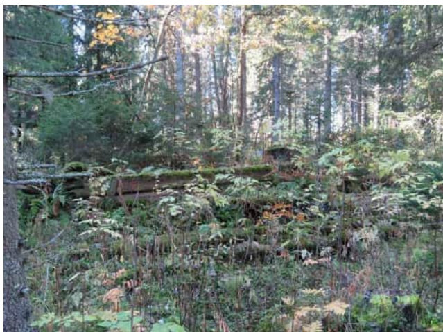
Alakohde 64–2. Rakennuksen säilyneitä hirsirakenteita.
