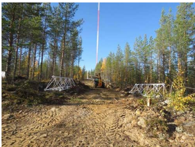
Kuva 27. Tulimittaustornin pystytys Isokankaan pohjoispuolella.
