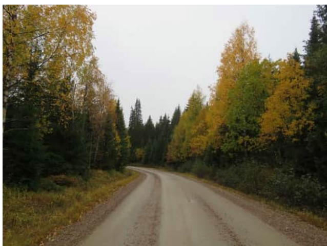
Kuva 2. Maantie Rötymäellä, kuvattu kaakkoon.
