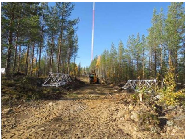
Kuva 27. Tulimittaustornin pystytys Isokankaan pohjoispuolella.
