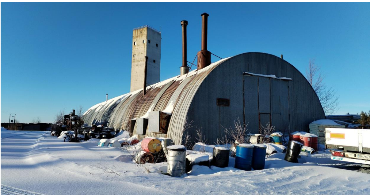
Kuva 45. Teräsrunkoinen, peltiverhottu kaarihalli sijaitsee pienen matkan päässä kaivostornista.
