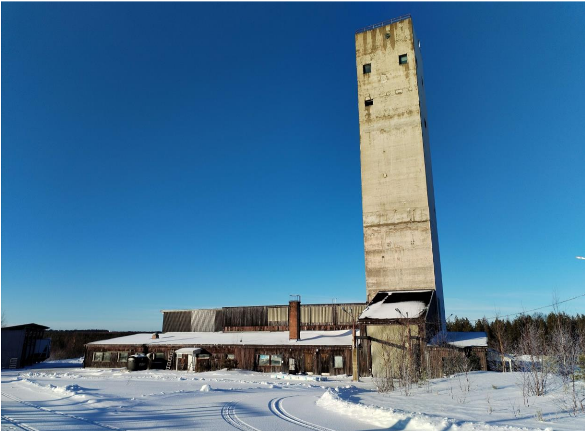
Kuva 44. Kaivostorni ja sen yhteydessä oleva rakennus. Kaivostorni on betonirakenteinen ja ulkomuodoltaan pelkistetty. Tornia ympäröi matala, lapekattoinen rakennus, jonka julkisivut ovat puuta ja peltiä. Rakennuksessa on mm. toimistotiloja, teollisen toiminnan tiloja ja varastotiloja. Ulkoasusta päätellen rakennusta on muutettu ja laajennettu useassa eri vaiheessa.
