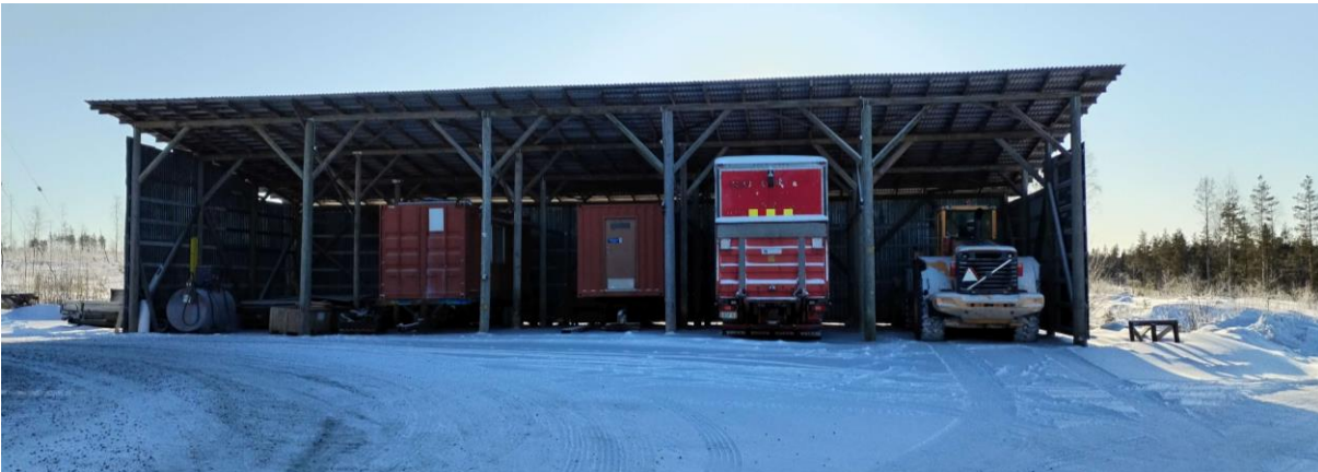
Kuva 46. Toiselta pitkältä sivultaan avoin konekatos on teräsrakenteinen, julkisivut ovat peltiä.
