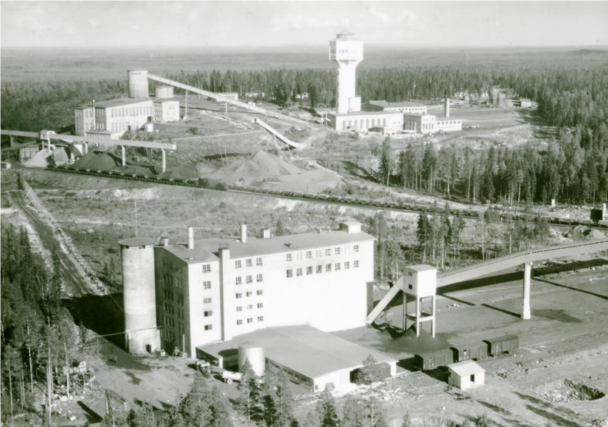
Kuva 48. Ilmakuva kaivosalueen rakennuksista (kuva: Kainuun Museo).
