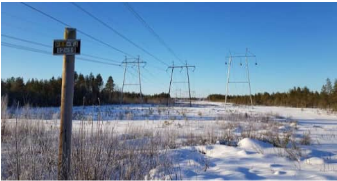
Sähköasema ja voimalinjat Humpinmäentieltä avautuvissa näkymissä.
