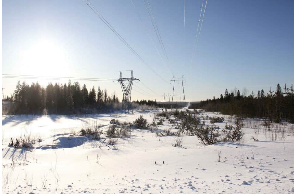
Voimalinjakäytävä Rynnäsentieltä lounaan suuntaan avautuvassa näkyössä.
