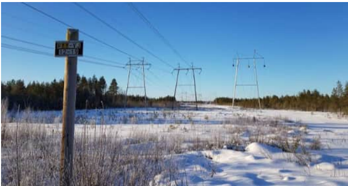
Sähköasema ja voimalinjat Humpinmäentieltä avautuvissa näkymissä.
